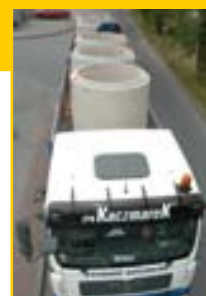
Transport prosto z fabryki na budowę
