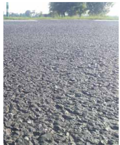
2. Wygląd nawierzchni z asfaltobetonu
