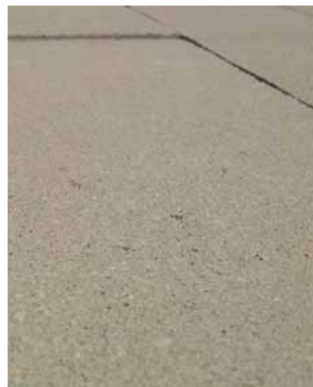
1. Wygląd nawierzchni z betonu wibroprasowanego
