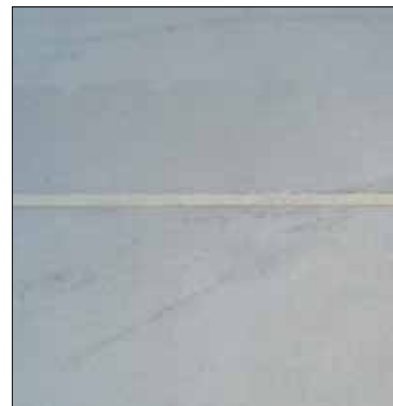
Fot. 9 | Widok bezfazowej dylatacji posadzki przemysłowej (zabezpieczonej materiałem elastycznym)
