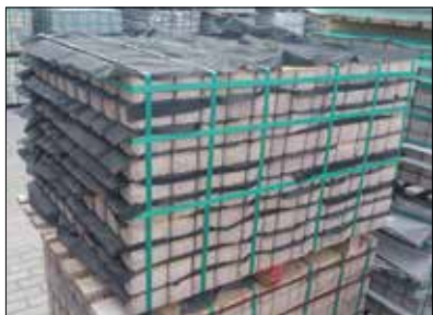
Fot. 7 | Zabezpieczenie warstw kostek agrowłókniną
