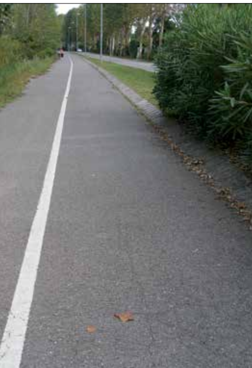
Fot. 1 | Nawierzchnia ścieżki rowerowej wykonana w technologii asfaltu
