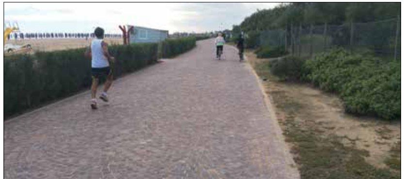
Fot. 6 | Nawierzchnia z kamiennej kostki brukowej
