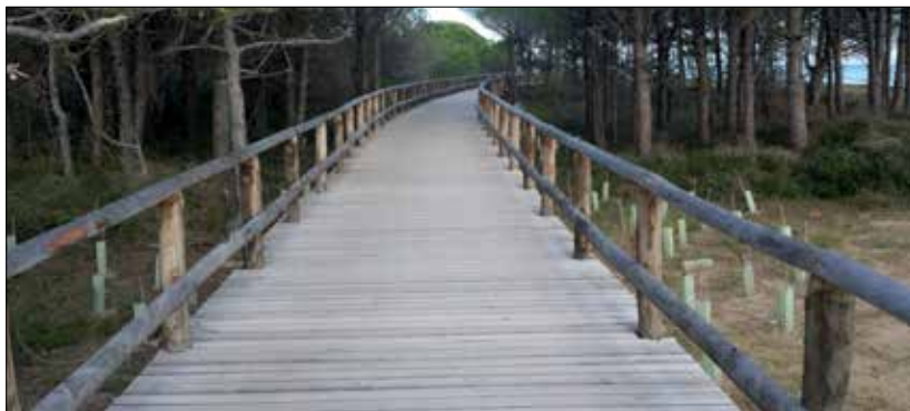
Fot. 8 | Drewniana nawierzchnia ścieżki rowerowej
