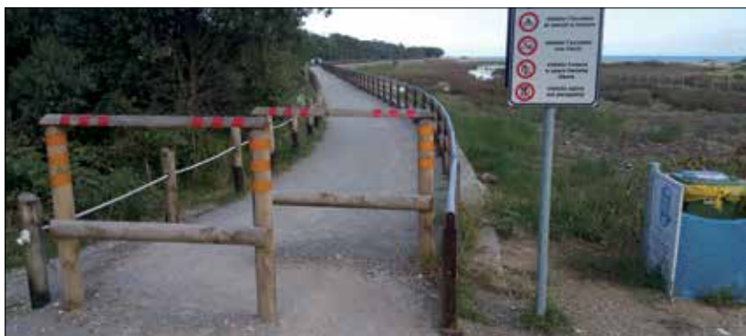
Fot.9 | Nawierzchnia z kłińca kamiennego
